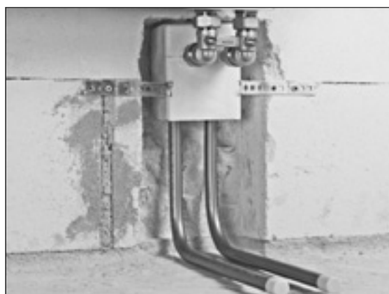
Присоединительный блок RAUTITAN для подключения отопительного прибора.
